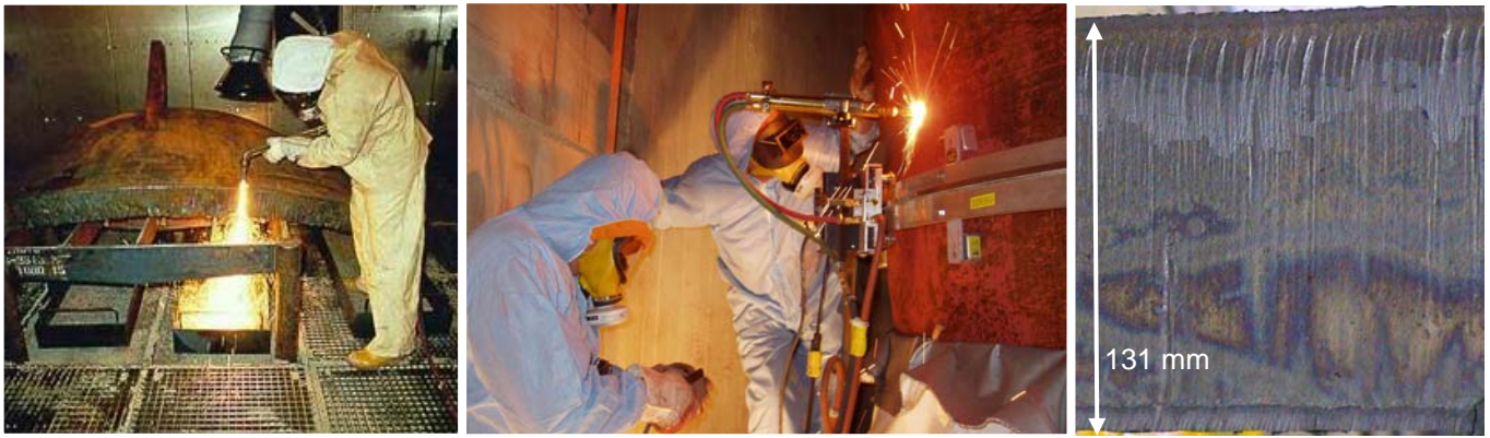
Abb. 9: Anwendungsbeispiele beim Rückbau kerntechnischer Anlagen [47],[48] links: Manuelle Brennschneiden des Reaktordruckbehälterdeckels Mitte: Fernhantierte Zerlegung des Reaktordruckbehälters rechts: Schnittfläche eines Reaktordruckbehältersegmentes
